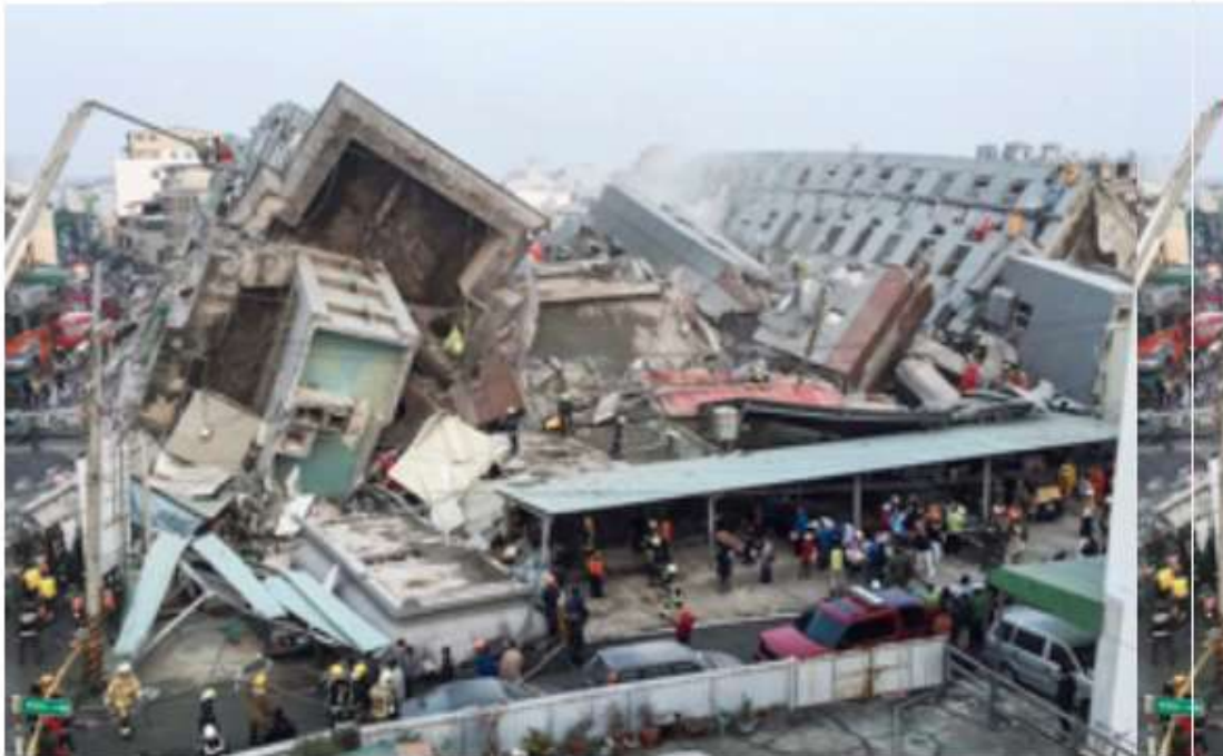
Bangunan runtuh akibat bencana gempa bumi. | Foto: Freepick
